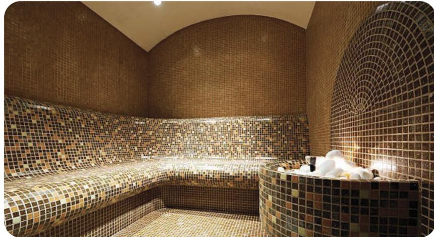
Il bagno turco è solitamente costruito all'interno di **una cabina in acciaio o alluminio** sull'imbarcazione, con **isolamento interno in EPS e XPS**, e rifinito con **piastrelle in mosaico Bisazza**. Le pareti e il soffitto sono **resistenti al fuoco**, classificati come **classe A1**, e la porta è antincendio, classificata come **classe A60**.
